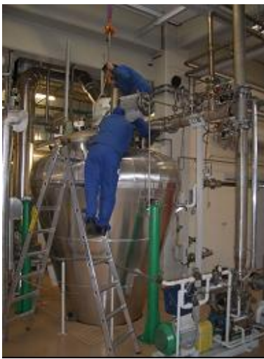
Umbauarbeiten an einem Orbitalschneckenrockner
